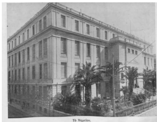
Φωτογραφία 7. Το κτίριο του Παλαιού Χημείου μετά την προσθήκη του τρίτου ορόφου.
