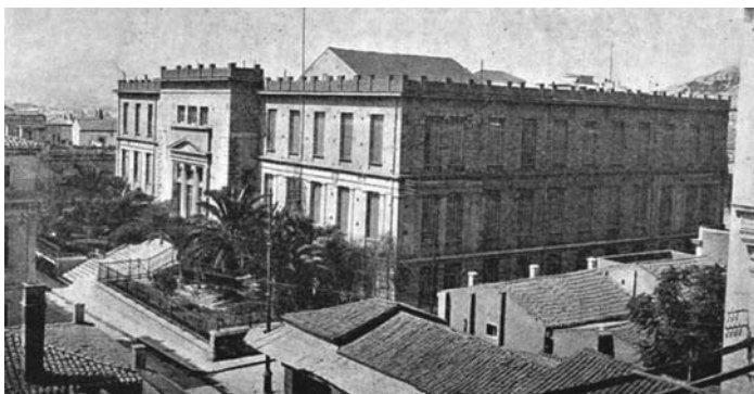
Φωτογραφία 6. Το αρχικό κτίριο του Παλαιού Χημείου
